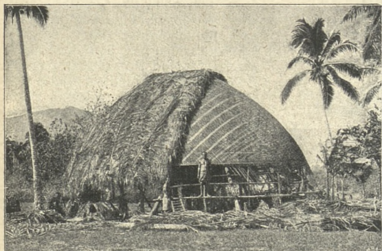
Stavba chaty na Nových Hebridách.
